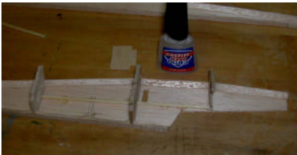
11- les lisse en pin 2x2 sont positionnées à l'aide des couples (non collés !) et pointées à la cyano (elles ont pour but de rigidifier les flancs au droit des ailes, particulièrement après le cintrage de l'avant et de l'arrière)
